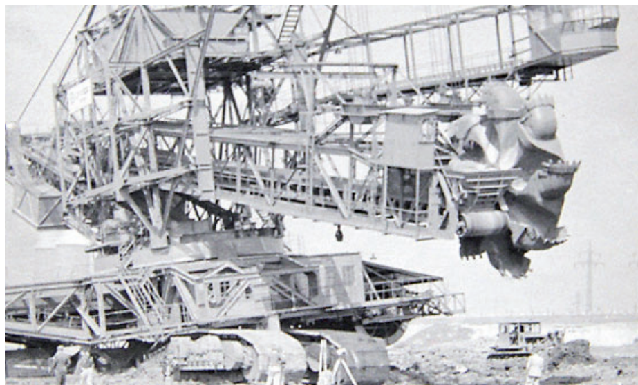
Úplně nový velkostroj byl samé bahno, měl zohýbané rámy u převodovek, poškozené ochozy, mazání pojezdů i potrahanou kabeláž. Foto: Oblastní archiv Most
