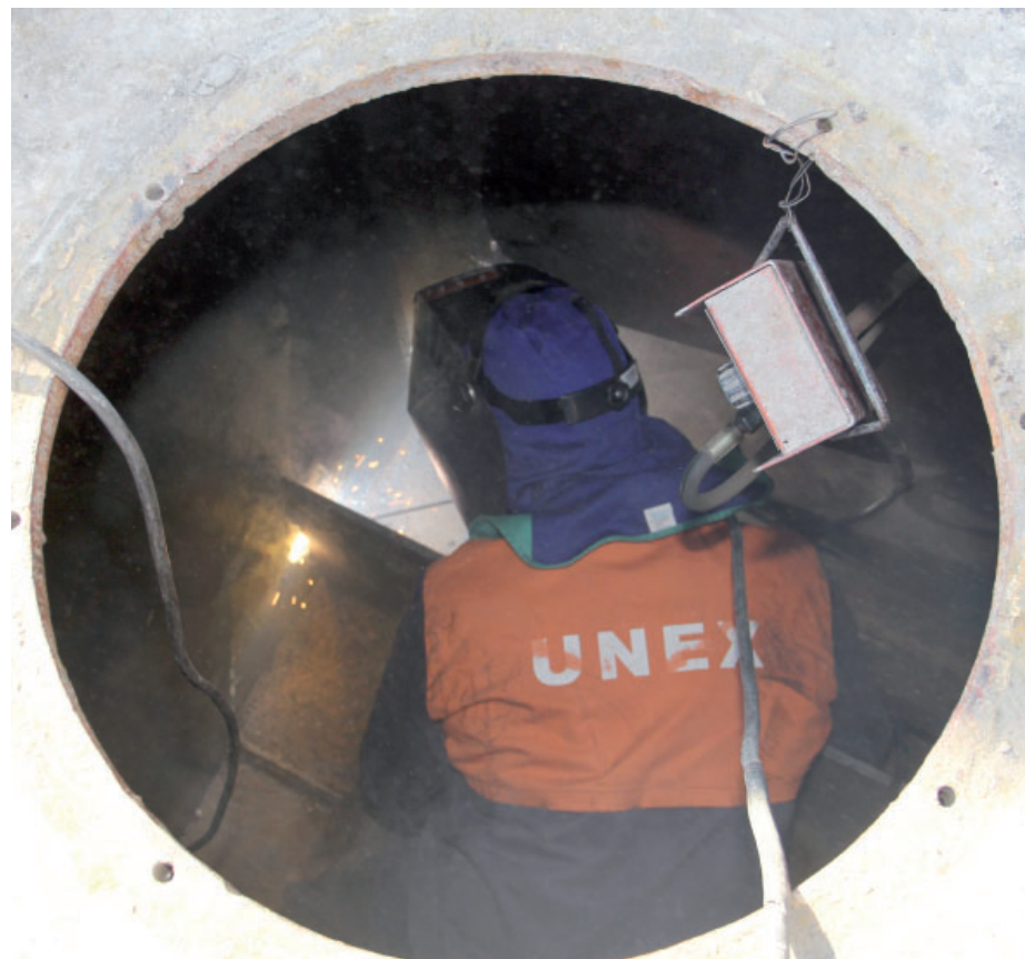
Práce probíhají uvnitř chodidel rypadla. Foto: (pim)
