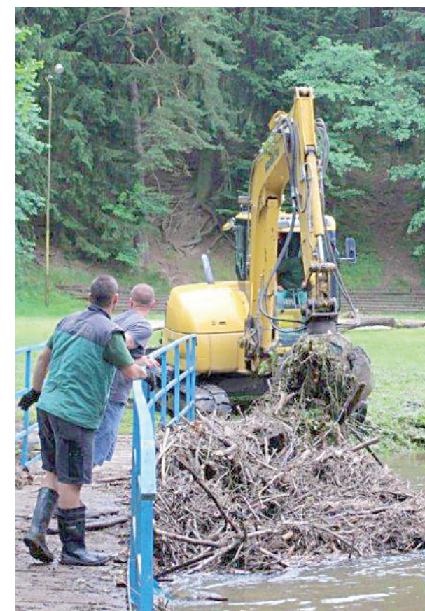
Osmadvacátého června šachetní technika pomáhala s odklizením naplavenin.
