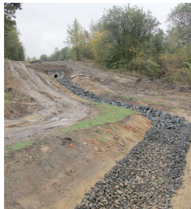
Už na sklonku loňského roku byl dokončen takzvaný V příkop, který slouží k odvodnění západní části Ressleru. Foto: Archiv DN
