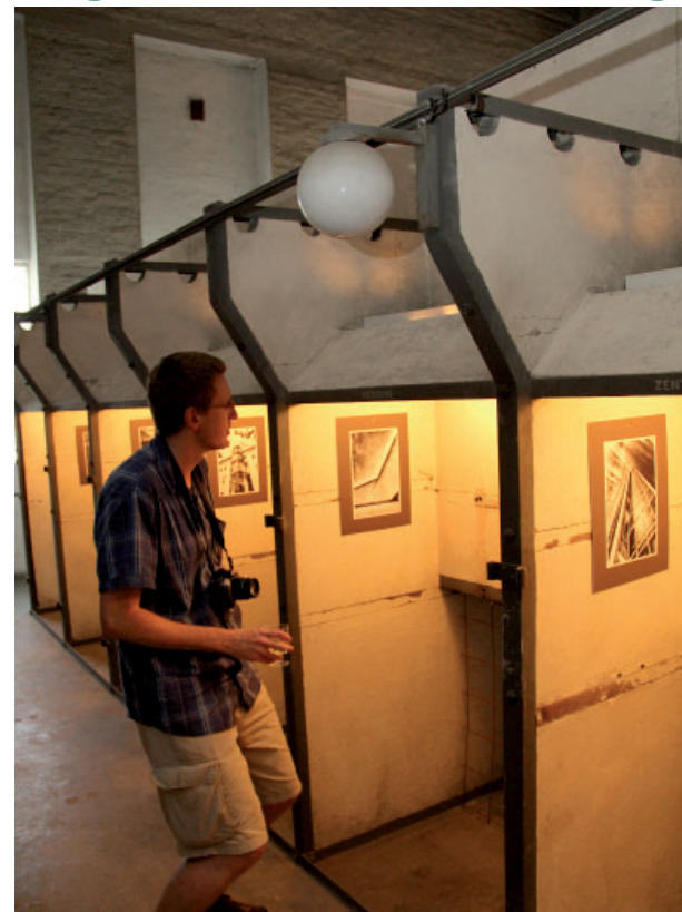
Bývalá rozvodna má jako galerie své kouzlo. Foto: Archiv DN
