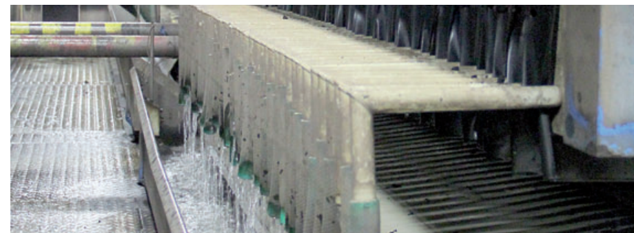
Z téhle pípy si pít k obědu radši nečepujte, proudí jí profiltrovaná voda z kalolisů. Foto: (pim)
