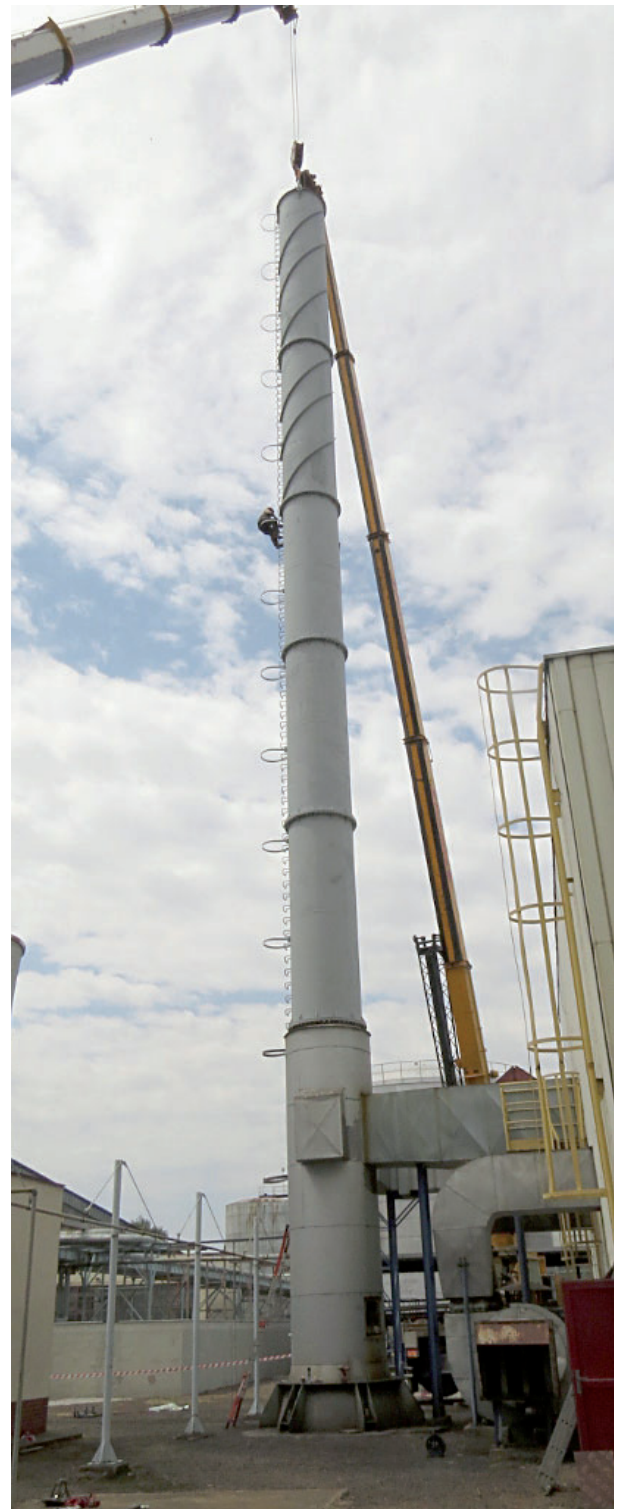
Nový komín najížděcí kotelny chvaletické elektrárny měří 35 metrů a je složený ze dvou kusů. Foto: (kapr)
