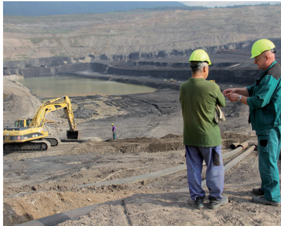
Vedoucí úseku odvodnění Severní energetické Petr Sigmund (vpravo) při kontrole prací těsně před dokončením přestavby. Foto: (pim)
