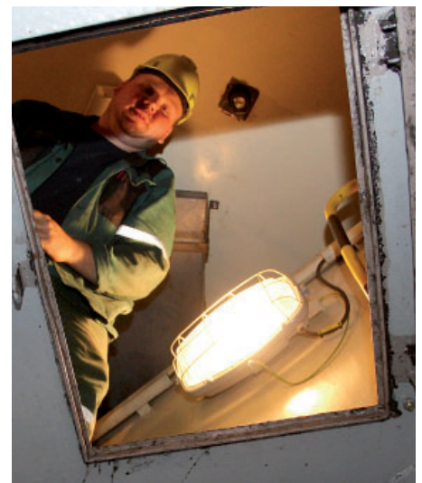
Údržbě a čištění neunikly ani útroby rypadla, Karel Altrichter uvnitř kružkové komory napájení stroje. Foto: (pim)
