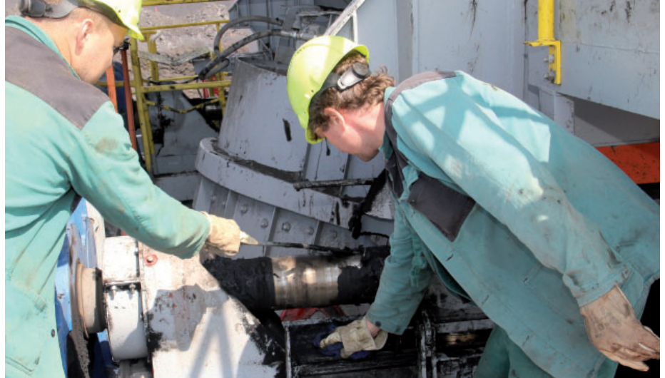
Vyčistit a zkontrolovat domky výsuvových šroubů na rypadle měli za úkol zámečníci Lukáš Chalupecký a Martin Hrubíšak. Foto: (pim)
