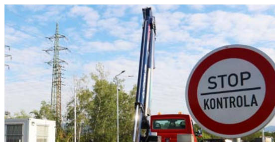
Celkový pohled na novou vrátnici D. Foto: (pim)
