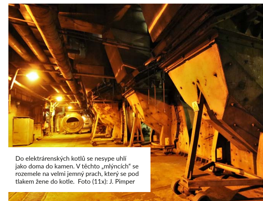
K regulaci výkonu bloku slouží tento řetězový podavač paliva.
